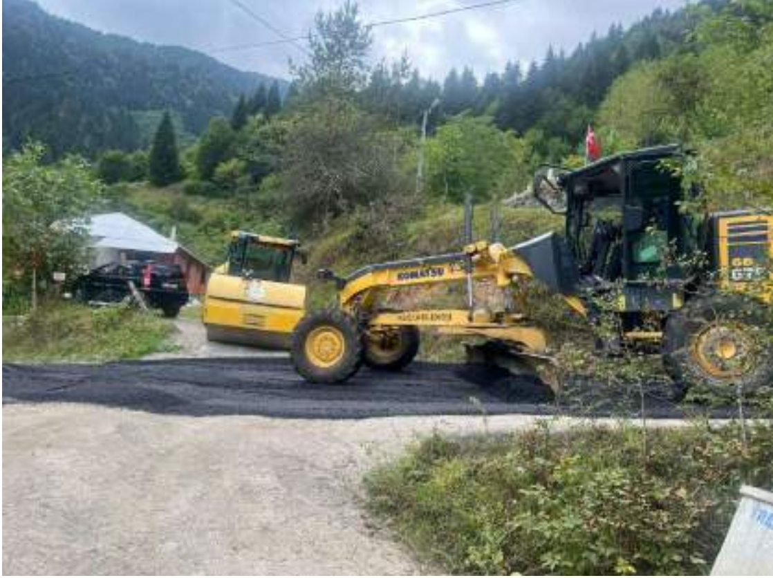
Bakımlı Mahallemiz asfalt çalışmamız.
